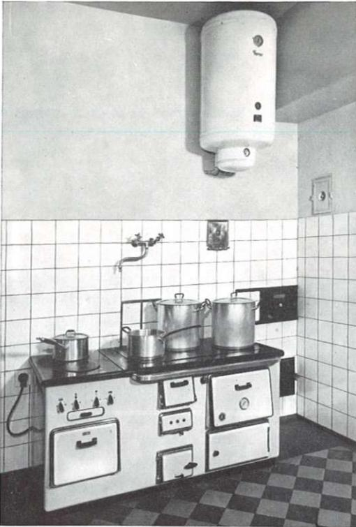
Boiler PYRAX raccordé à un fourneau mixte
